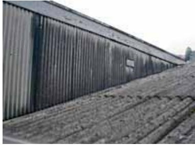
Lastre di copertura in cemento-amianto
