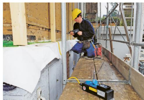
8 S'il n'y a pas d'ensemble d'appareillage de chantier à disposition, il faut brancher des disjoncteurs différentiels (DDR) mobiles.
